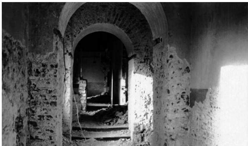
Trabajos en el interior.
