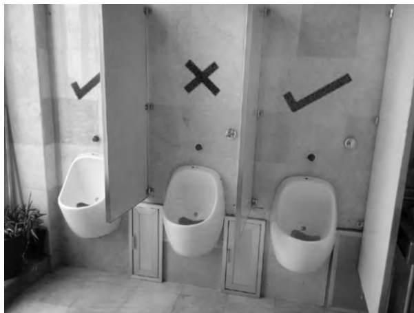
Adecuación de las instalaciones sanitarias para asegurar la sana distancia.
