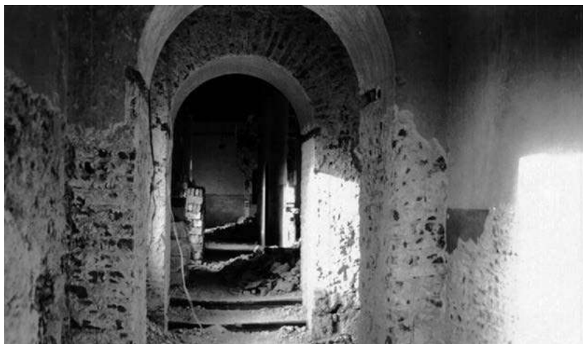
Trabajos en el interior.
