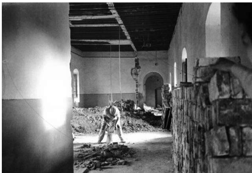
Trabajos en el interior.
