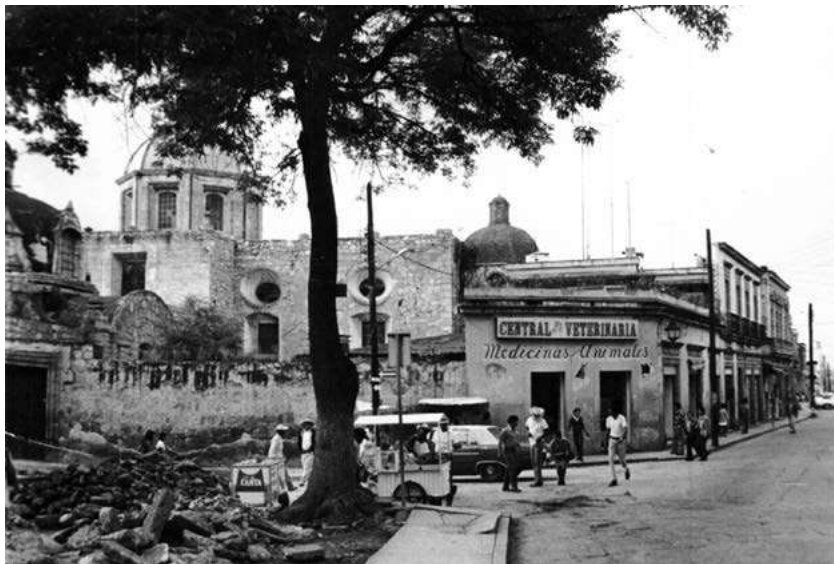
Exterior sobre la calle Morelos y construcciones adyacentes.
