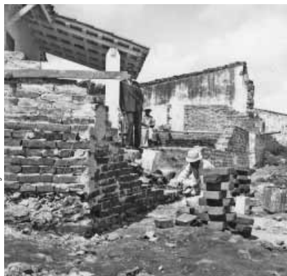
La faena constructiva.
