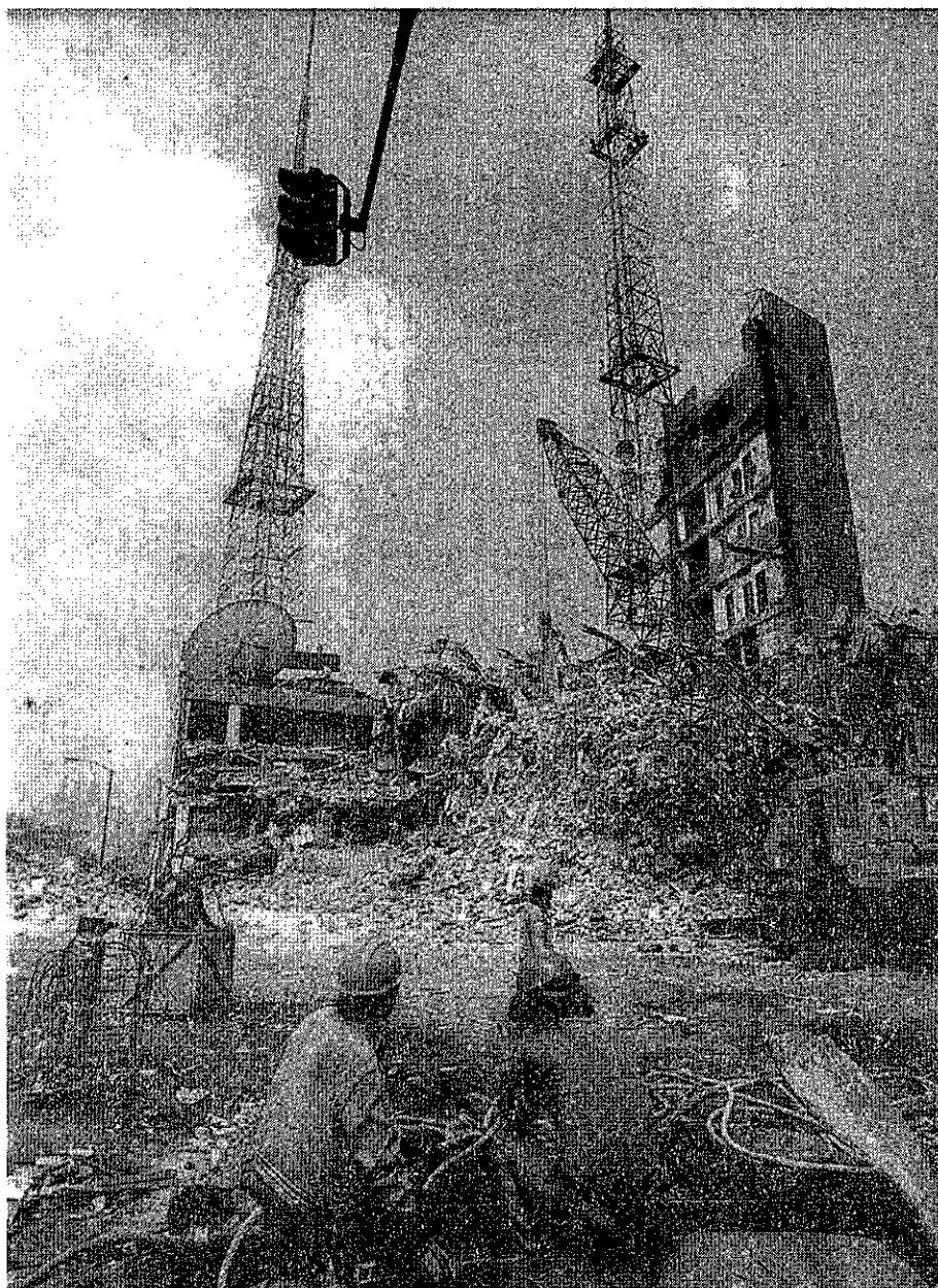
Edificio de Televisa después del sismo de 1985. Archivo General de la Nación, Crónica de la Presidencia, Miguel de la Madrid, Sismos.
